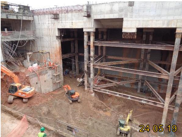
**Corpo de Estação:** Escavação sob a laje de cobertura da estação pelo Acesso Heitor dos Prazeres.
