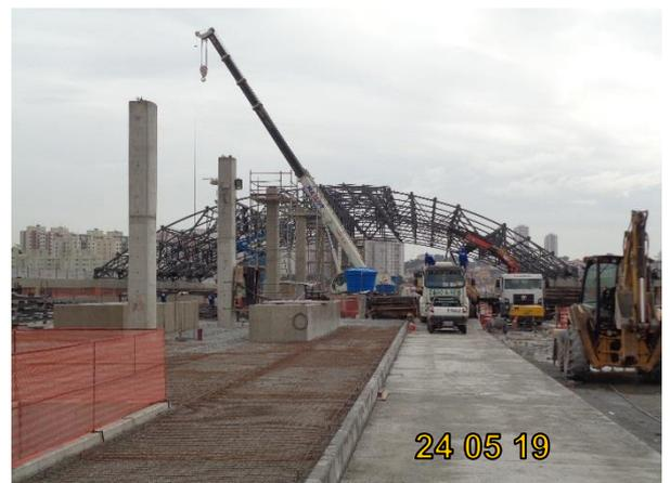
**Nível Terminal (Terminal de Ônibus Vila Sônia):** Em montagem a cobertura metálica.
