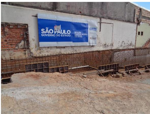
Obra Civil – execução do muro de contenção do Acesso Norte e implantação dos Sistemas.
