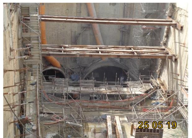
**VSE Edmundo Lins:** Em execução impermeabilização e revestimento secundário. Emboque dos túneis Singelo (Túnel 5) e Duplo (Túnel 4).
