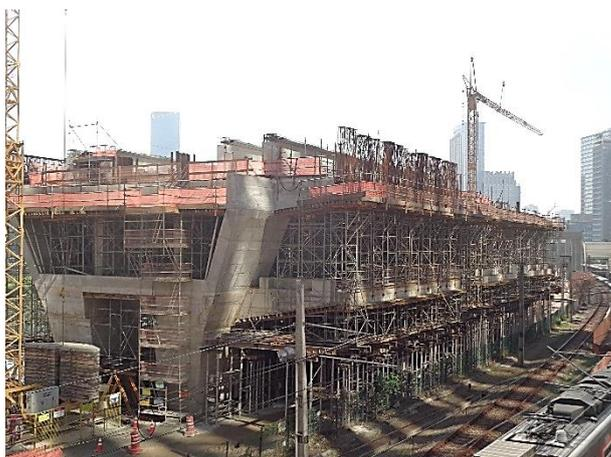
Execução das vigas na área do porão de cabos/ viga de apoio das plataformas.
