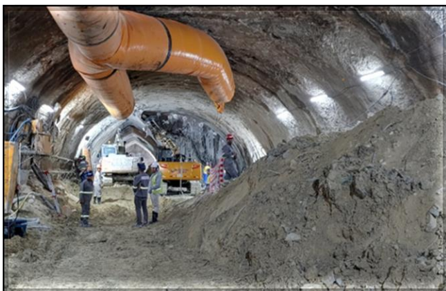
Escavação do túnel de via
