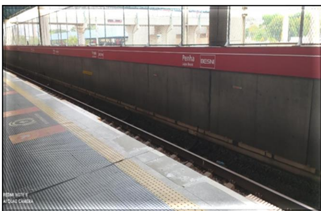
Reforço da borda da plataforma
