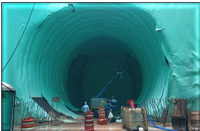
Impermeabilização do túnel de ligação finalizada.
