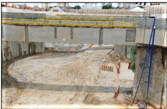
Escavação dos poços do corpo da estação.
