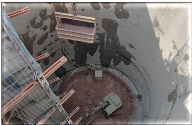
Escavação do poço.
