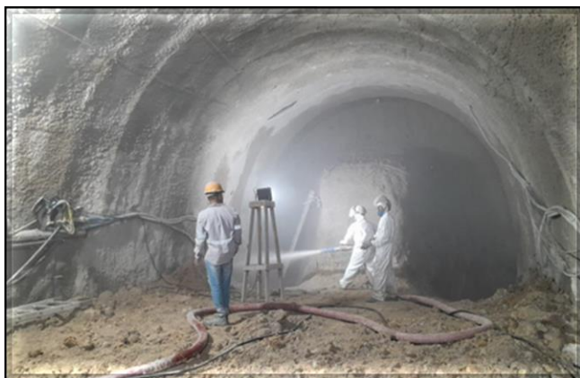
Escavação do túnel singelo.
