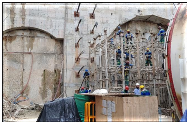
Corte da parede da vala para partida da Tuneladora.
