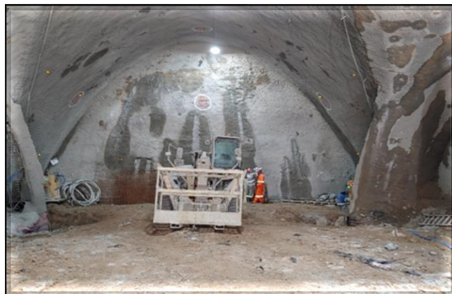
Escavação dos túneis do corpo da estação.
