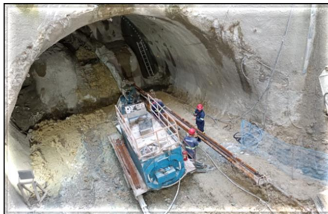
Escavação do túnel de ligação.
