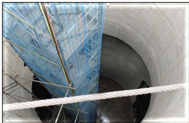
Revestimento secundário do poço finalizado..
