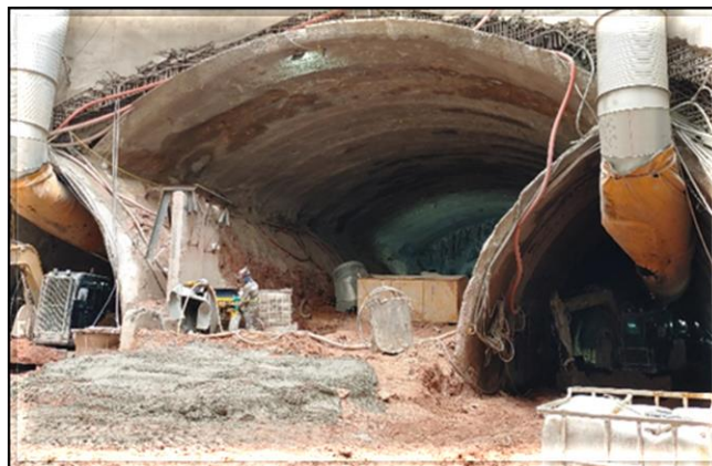
Escavação do túnel de transição.
