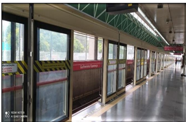
Montagem das fachadas nas vias 1 e 2
