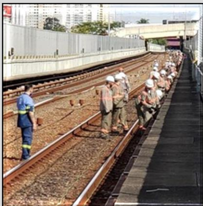
Lançamento de cabos do CBTC
